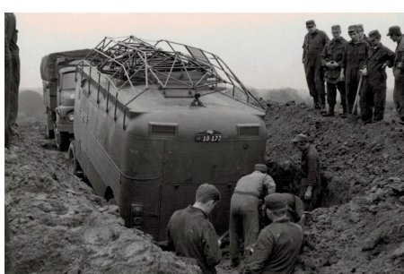
Nedgravning af Søgeradar M/64
