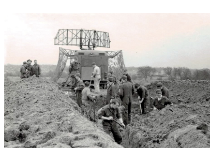
Nedgravning af Radar M/64
