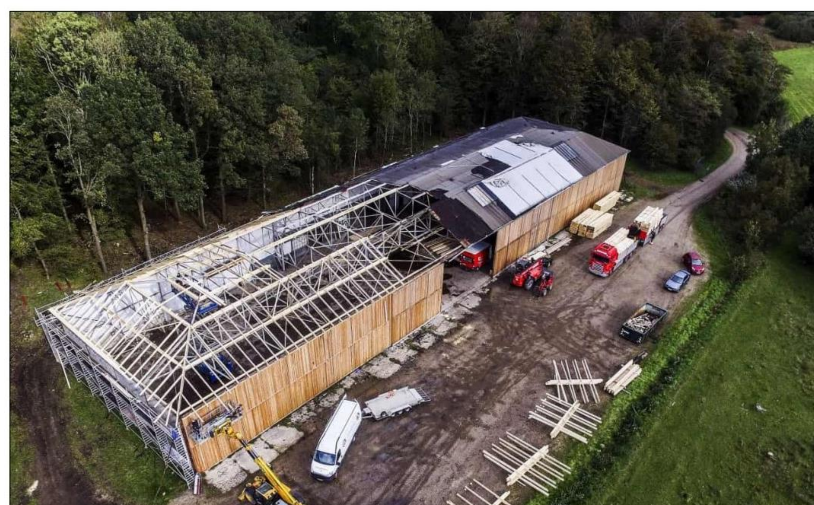
Flyhangar i Soldaterskoven i Tønder fra renoveringen af blandt andet tag og sider.
