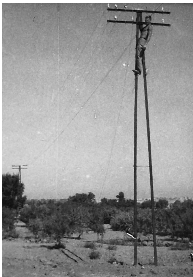
Nogle kabler anbringes i høje master
