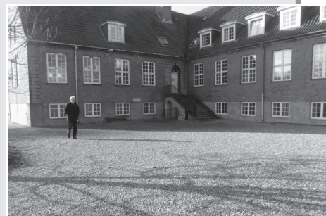
Indkvarteringsbygning og nedgang til cafeteria
