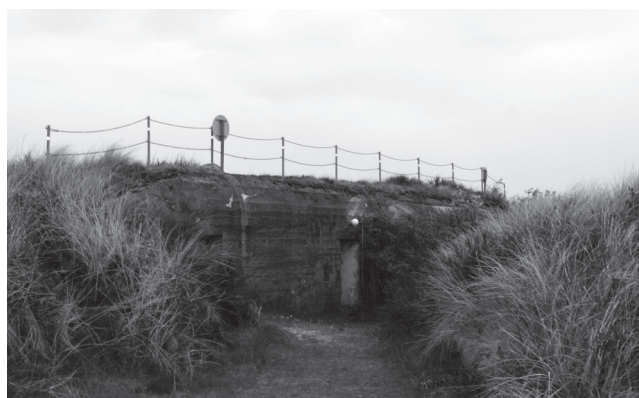
Bunker i lejren
