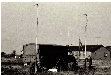
Opstilling af antennemaster
